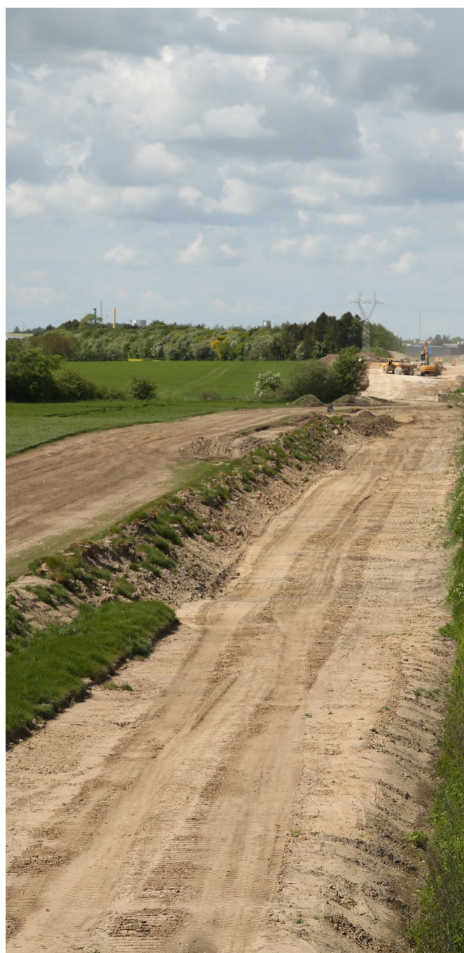
Eksempel på sporarbejde ved Kværkeby, hvor jorden bliver planlagt, så der kan anlægges dobbeltspor til Den nye bane København – Ringsted.
