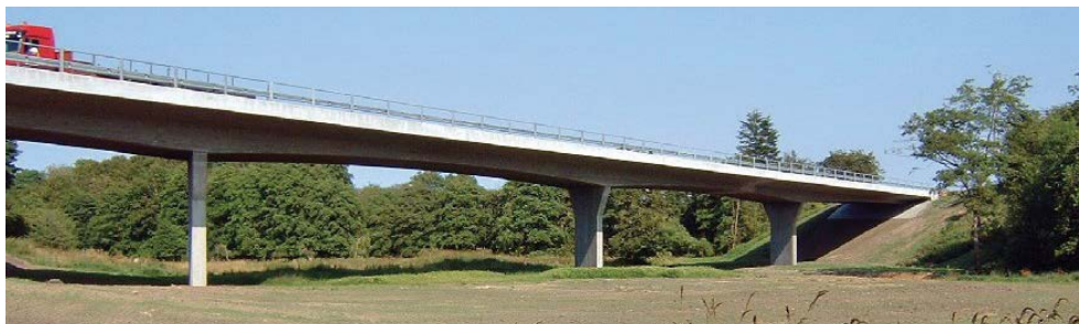
Figur 7. Flerfags bjælkebro (motorvejsbærende bro vist).
