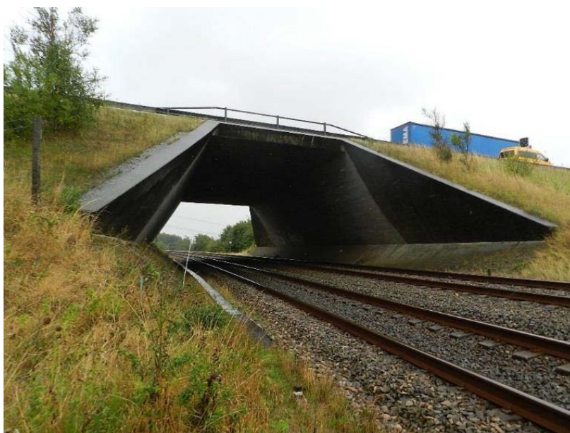
Figur 5. Vejbro som rammebro i beton.
