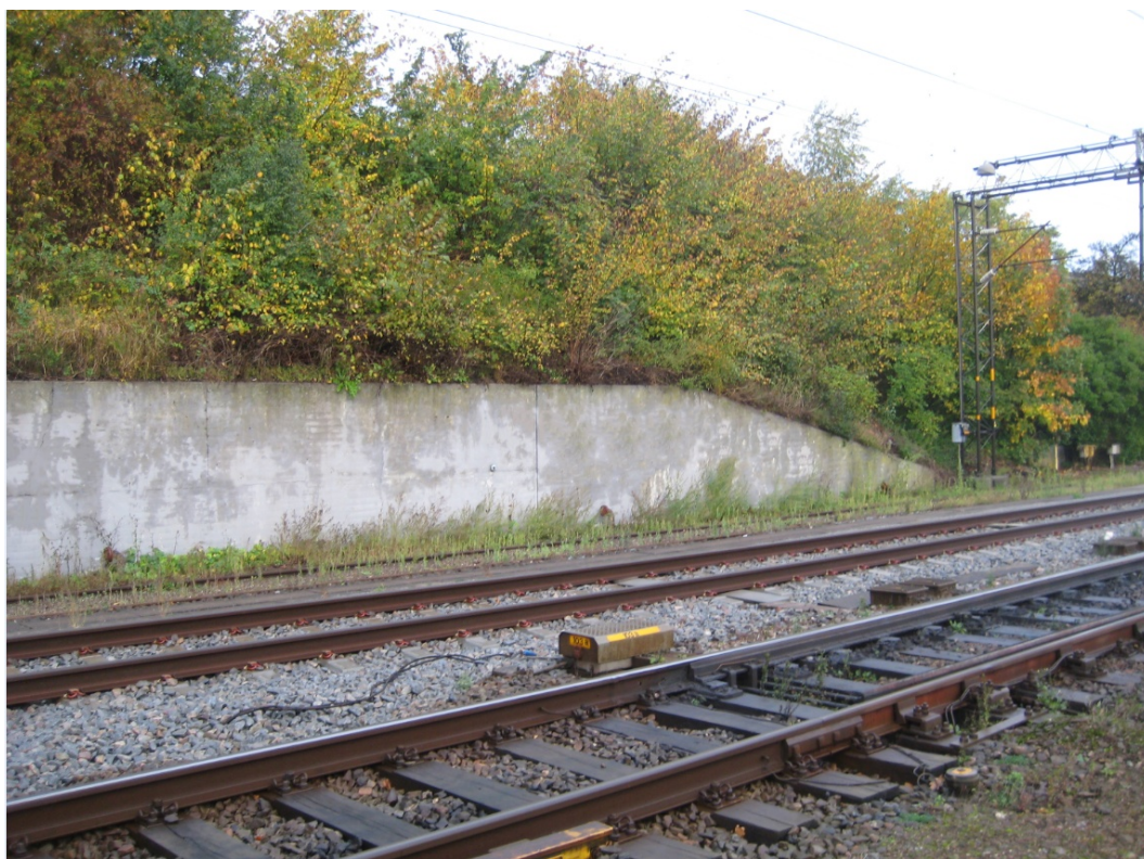
Figur 10. Støttevæg i beton langs bane.
