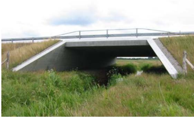
Figur 8. Faunapassage som skråvægsrammebro.
