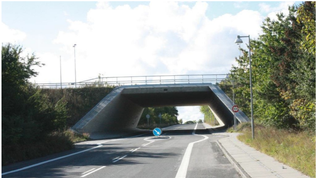
Figur 6. Jernbanebro som rammebro i beton.
