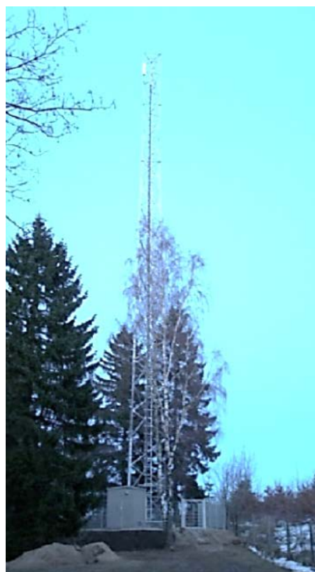
Figur 19. 45 m høj antennemast (Foto udlånt af Banedanmark/Rambøll).
