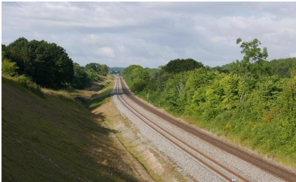
Figur 7-11 Udsigt fra banebro ved Dellingevej med kig mod Lejre. Banen ligger i dyb afgravning.
