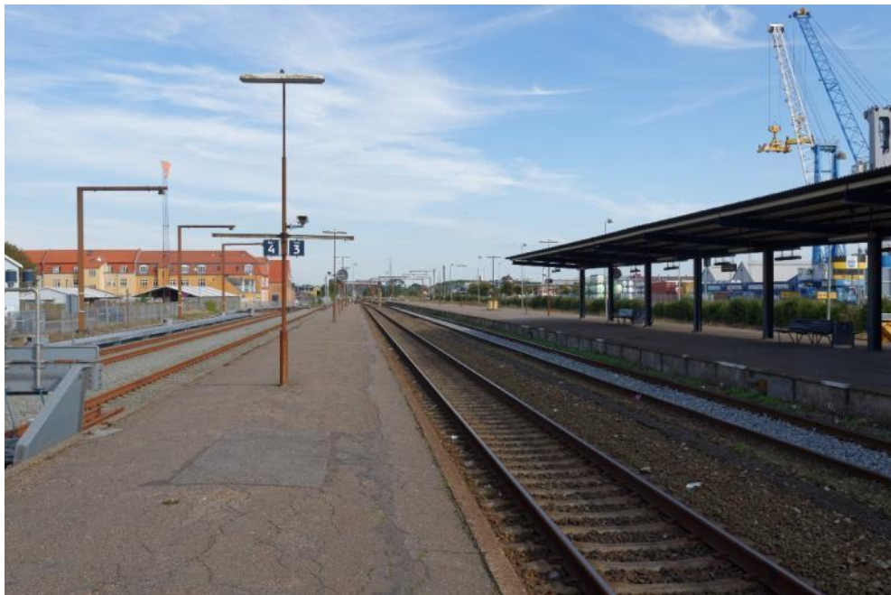
Figur 1-1 Kalundborg Station skal også elektrificeres
