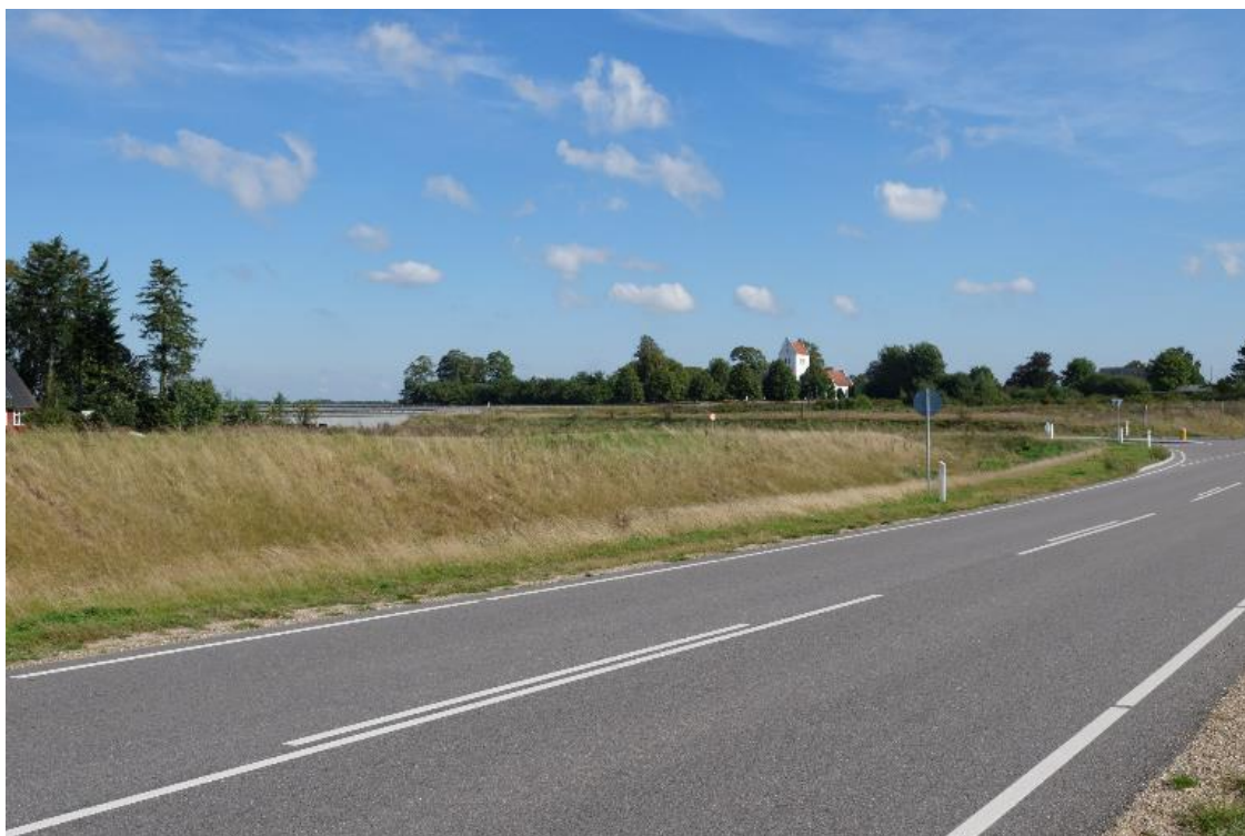
Figur 9-71 Dagens situation før opsætning af master og køreledninger. Soderup Kirke set syd fra med jernbanen i forgrunden.
