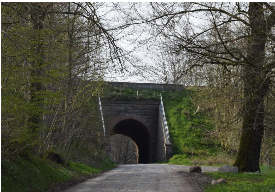
Figur 15: Velbevaret stenbygget jernbanebro fra 1868 på Tirsbækvej, km 32,9, ved Tirsbæk Gods i Vejle Kommune.
