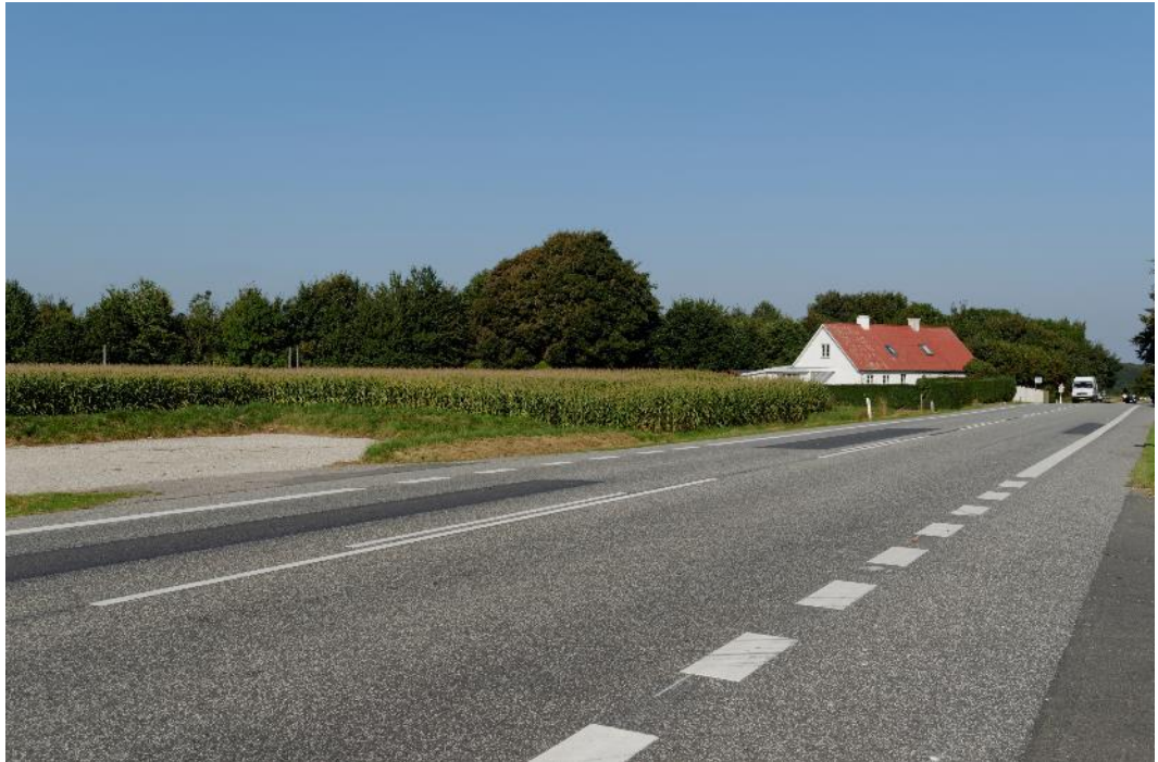
Figur 45: Standpunkt 10 - Hattingvej, bro 20680. Foto af eksisterende forhold ved Hattingvej ved bro 20680. Fotoet er taget fra Hattingvej set med nord.
