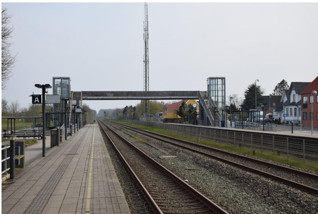
Figur 14: Hedensted Station. En perronbro krydser over banen med et elevatortårn på hver side. Stationen opleves generelt som åben.
