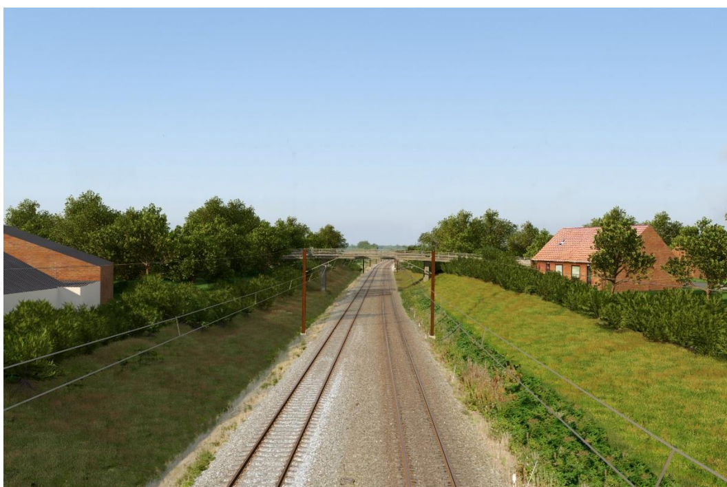
Figur 40: Standpunkt 7 – bro 20660 i Løsning. Visualisering af køreledningsanlægget og den hævede bro på Nørregade.
