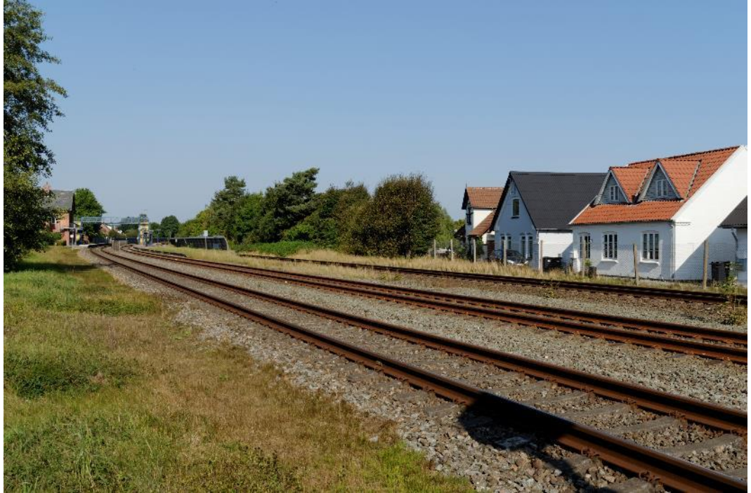
Figur 35: Standpunkt 3 – Børkop Station. Foto af eksisterende forhold ved Børkop Station.
