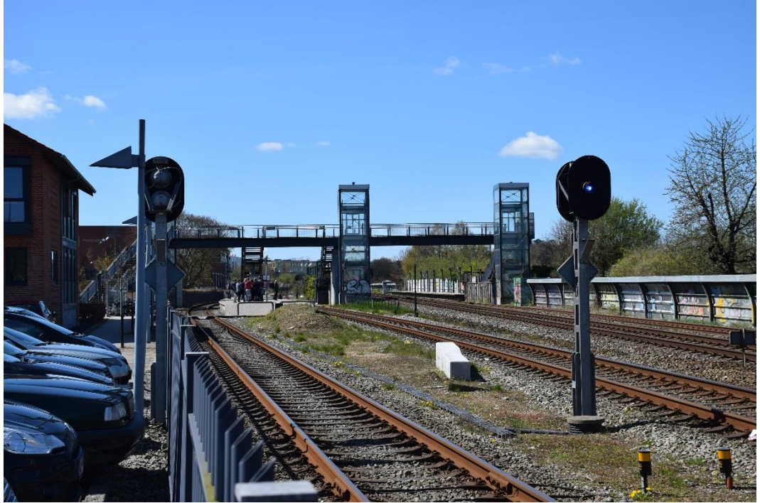
Figur 27: Viby J Station. En perronbro føres over sporene, og de tre elevatortårne fremstår markant i stationsområdet.
