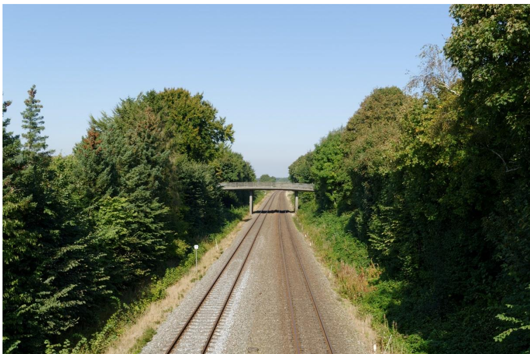
Figur 39: Standpunkt 7 – bro 20660 i Løsning. Foto af eksisterende forhold ved Nørregade. Fotoet er taget fra gangbroen syd for.
