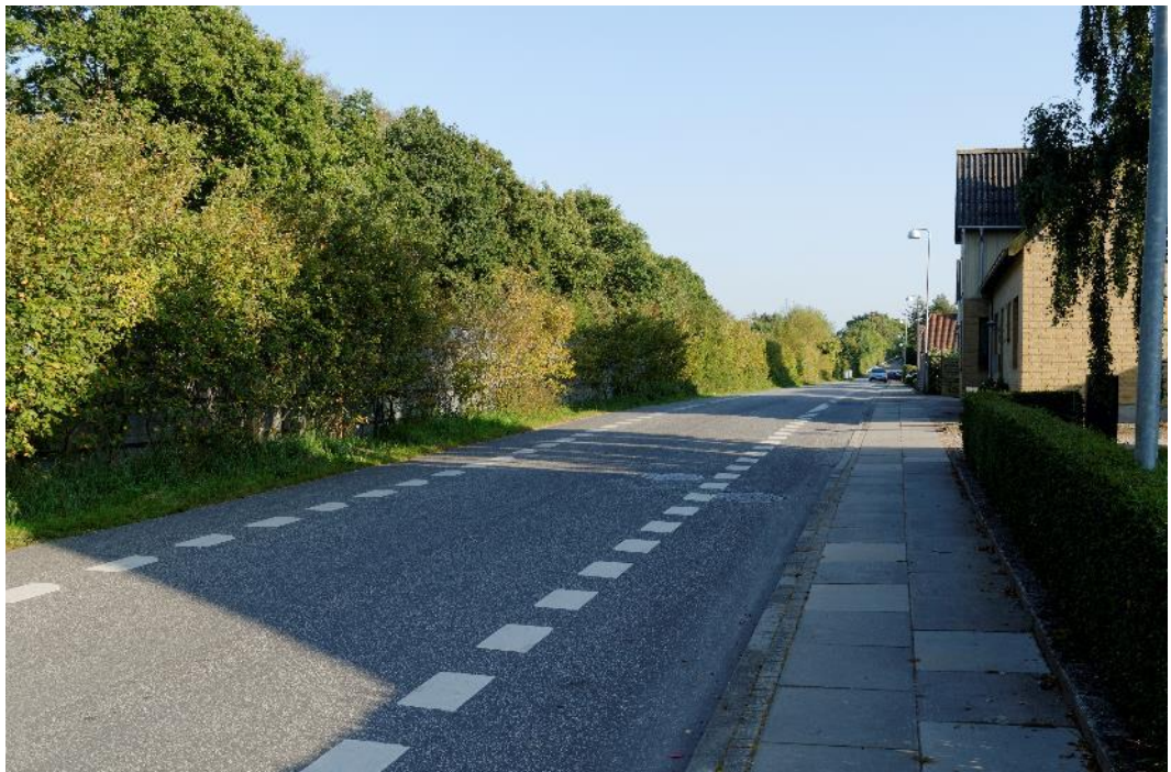
Figur 49: Standpunkt 13 - Hylkevej, bro 20764. Foto fra Hylkevej set mod sydvest mod Båstrupvej, bro 20764.
