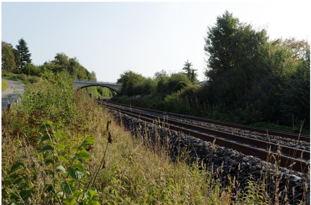
Figur 57: Standpunkt 16 - Korsvej, bro 20788. Foto af eksisterende scenarie ved Korsvej, bro 20788 (førbillede).
