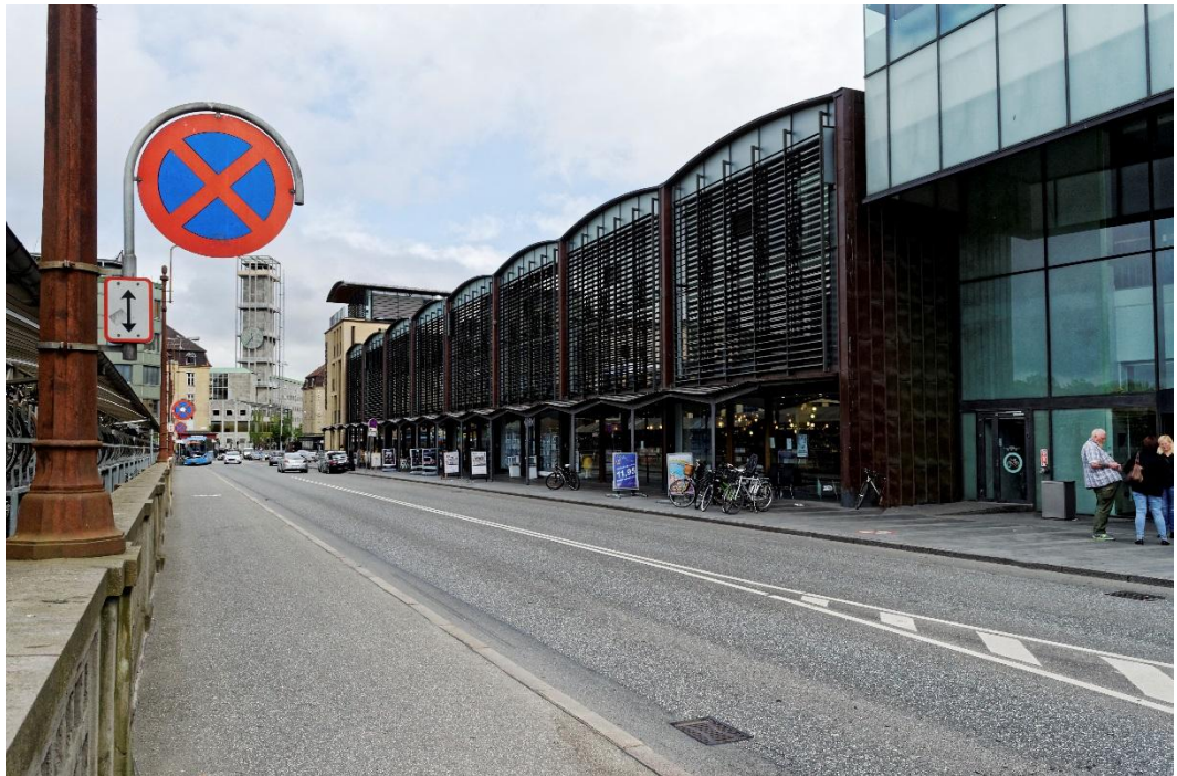
Figur 14 Fotostandpunkt nr. 5. Eksisterende forhold på M. P. Bruuns Gade, set fra den sydlige del af Bruuns Bro. (Foto: COWI)
