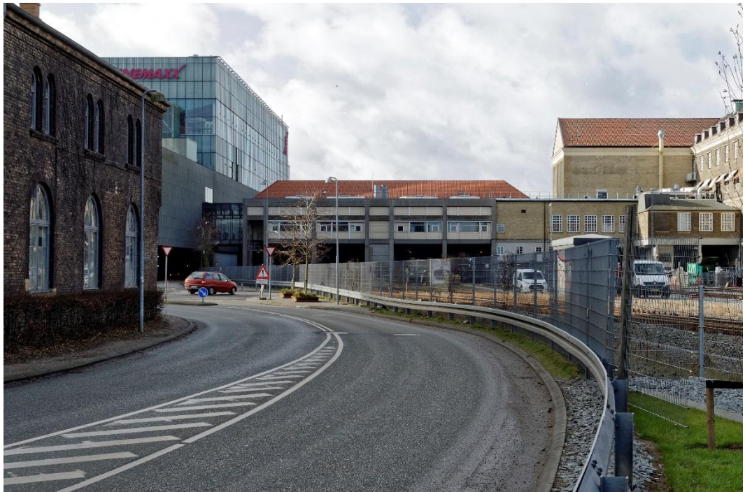
Figur 18 Fotostandpunkt nr. 4. Eksisterende forhold set fra Værkmestergade øst for Aarhus H. (Foto: COWI)
