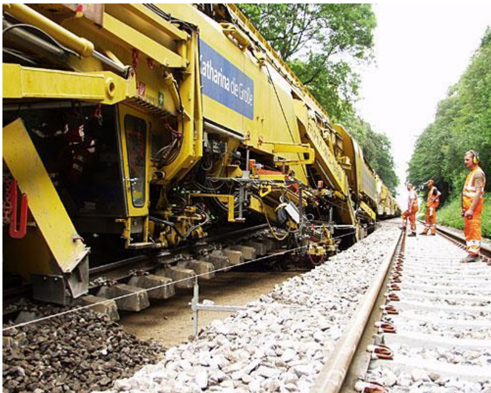
Figur 2. Maskine til udskiftning af bund og andre dele af en bandedæmning.
