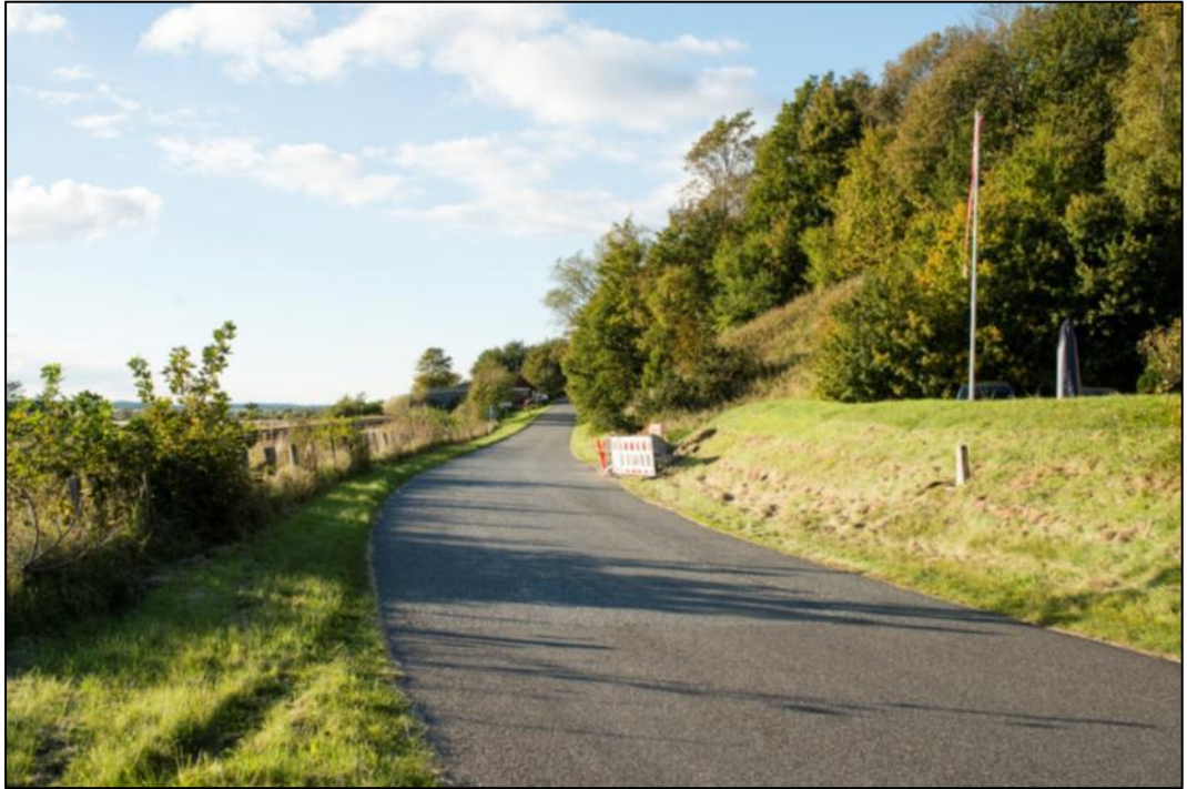
Figur 79. Ørrildvej i Randers kommune mod sydøst, eksisterende forhold.
