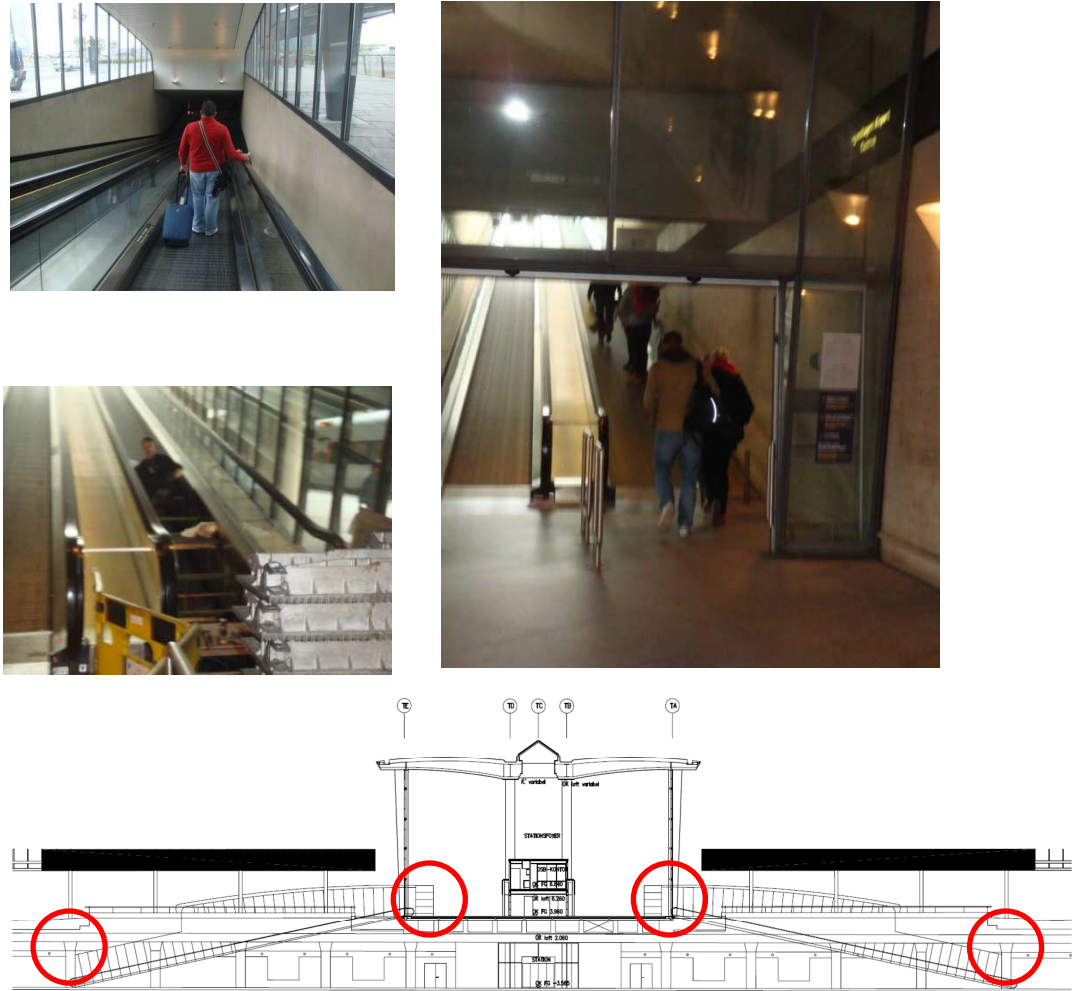
Figur 12: Trappeadgange, rullefortov fra perron til Terminal 3. Rødmarkering viser områder med eksisterende glasskydedøre, som antages at være brandsikret imod en 30 minutters brand. Fotos viser den øvrige glasomslutning af trappe, som også antages at være brandsikret til 30 minutter.
