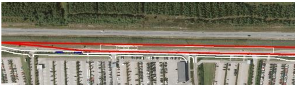
Figur 10. 288 meter lang perron for stationen langs Lufthavnsvej.
