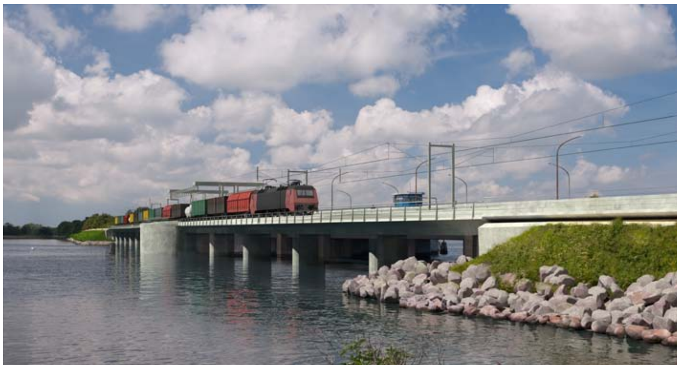
Påvirkning af omgivelserne, når blandt andet en ny bro over Guldborgsund opføres, er undersøgt.
