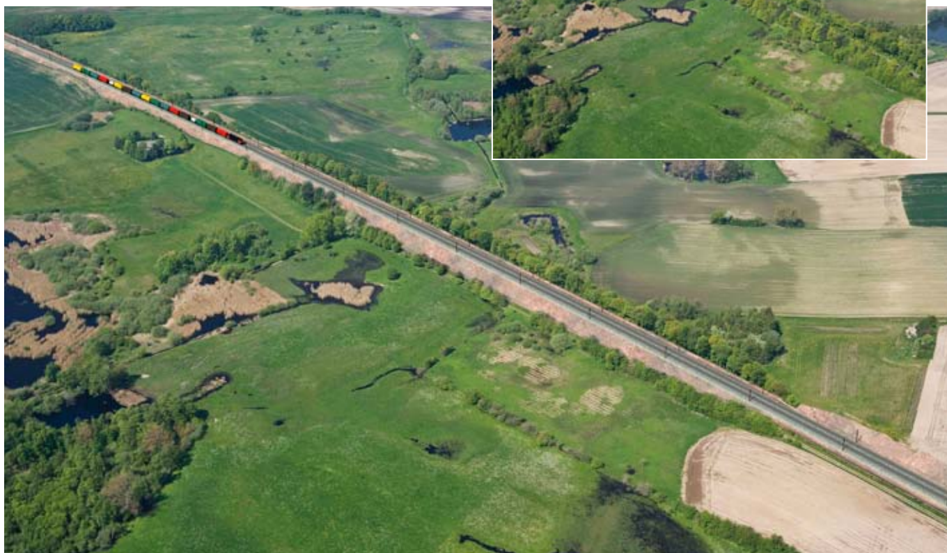
Jernbanen bliver i en årrække mere synlig i landskabet, når der etableres et ekstra spor og kørestrømsanlæg. Det ses blandt andet ved Musse Mose, hvor banen passerer et større område med beskyttet natur.
