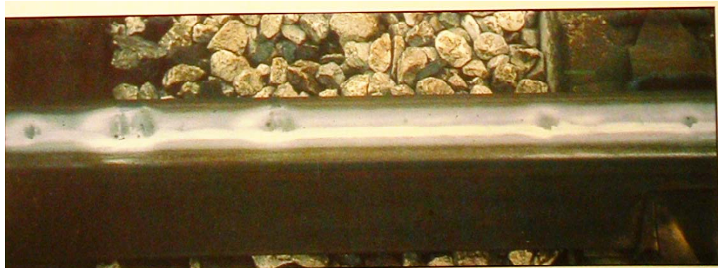
Alvorlig skinnepletter, med ”åndehul” til overflade
