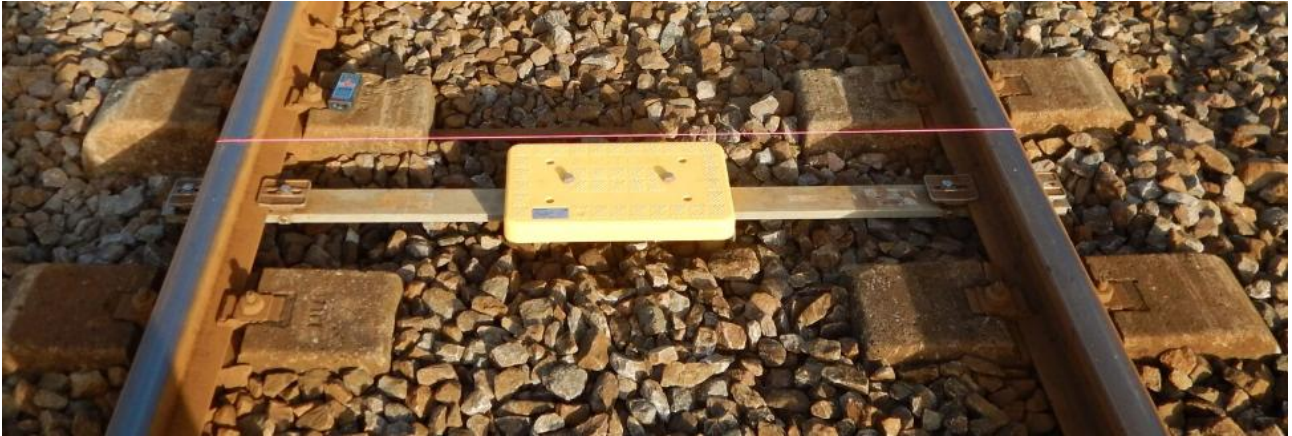
Eksempel på balise monteret på skinner mellem 2 sveller
