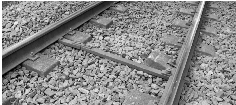
Figur 115 – Afstandsjern ved knækket to-blokveller
