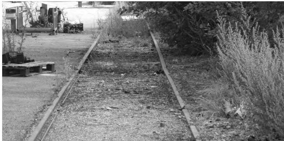
Figur 335 – Snæver sporvidde forårsaget af dårligt laskestød
