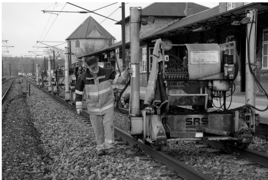
Figur 281 – SUM trin 4: Den øverste del af SUM-udstyret køres til næste løft (f.eks. ilægning af ny sporramme)
