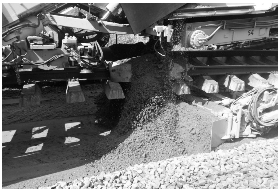
Figur 56 – Ilægning af ny underballast
