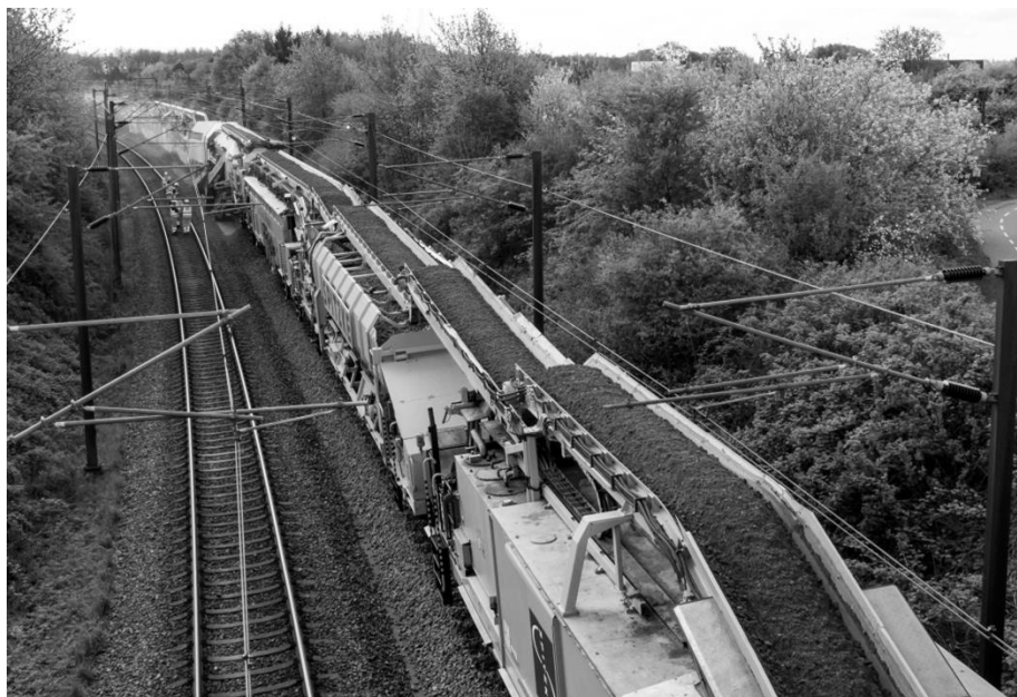
Figur 55 – Transport af ny underballast frem til arbejdsområdet fra trukne materialevogne
