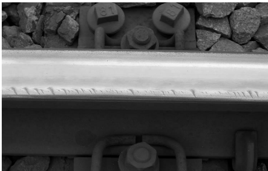
Figur 110 – Kørekantsrevner (head checks)
