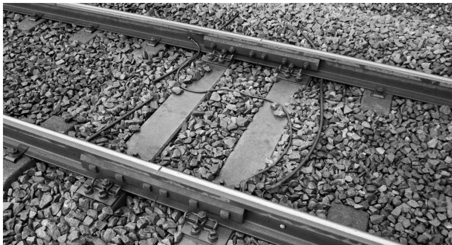
Figur 222 – Rette isolerklæbestød på SP90-sveller
