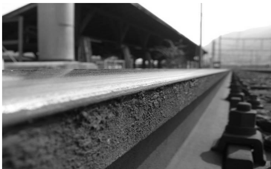
Figur 337 – Snæver sporvidde pga. "skæg" (udpresset skin- nehoved)
