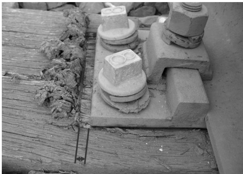
Figur 336 – Bred sporvidde pga. befæstelsen har skubbet sig i svellen
