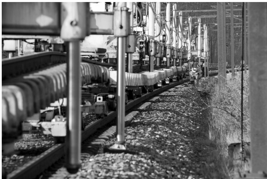
Figur 280 – SUM trin 3: Sporrammen løftes af vognene, så den kan trækkes ud for at blive brugt igen
