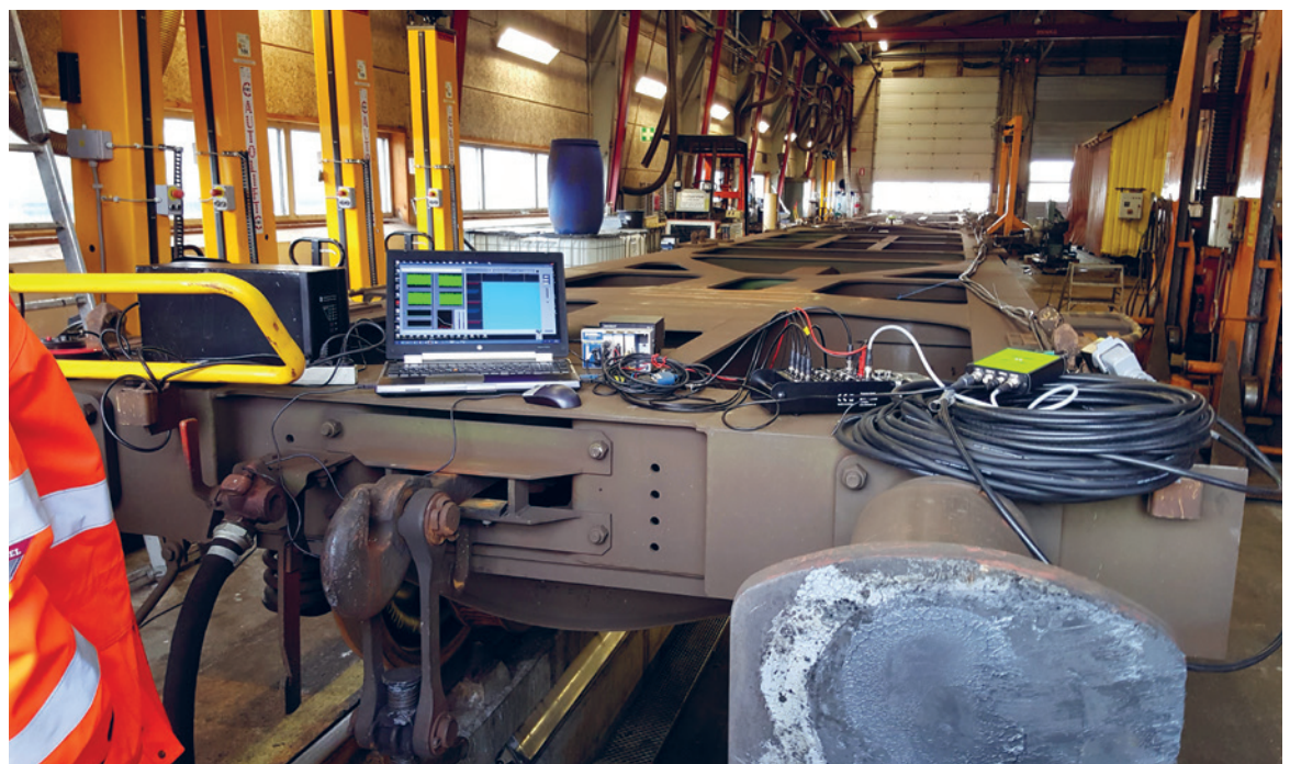
PÅ TUR MED MÅLETOGET. Rent praktisk foregår støjmålingen ved, at der spændes en godsvogn bag det måletog, der hvert år kører rundt på jernbanen for at finde skinnedefejl. Her er måleudstyret ved at blive monteret. Foto: Bane Danmark
