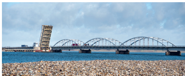
ODDESUNDBROEN. Inden entreprenøren når så langt som til at male Oddesundbroen, skal den gamle maling renses af; og det helt ind til det blanke stål. Foto: Jens Bach
