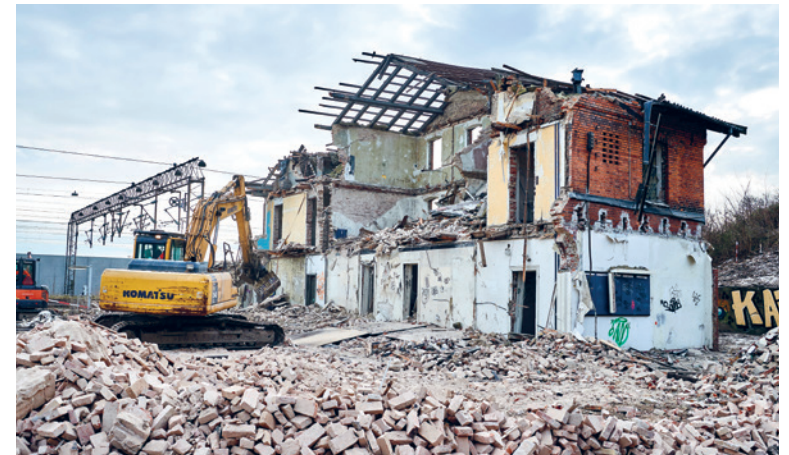
FRA REMISE TIL OPLAGRINGSPLADS. Remisen i Helsingør har ikke været i brug i flere år. Nu skal der være oplagingsplads og plads til arbejdskøretøjer. Foto: Jesper Blæsild
