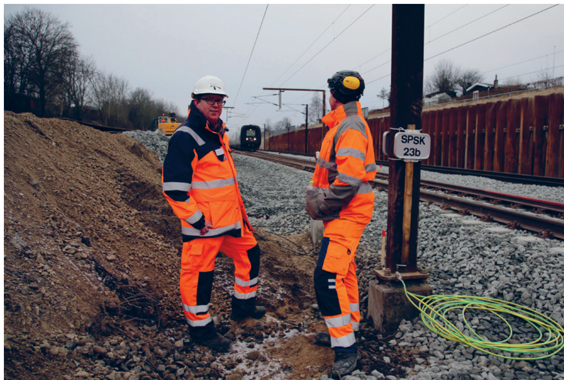
NYE SPORSKIFTER. Assisterende byggeleder Mikkel Botoft Nielsen fra Den nye bane København-Ringsted (tv.) inspicerer et af vinterens nye sporskifter øst for Ringsted Station sammen med en SR-leder. Foto: Banedanmark
