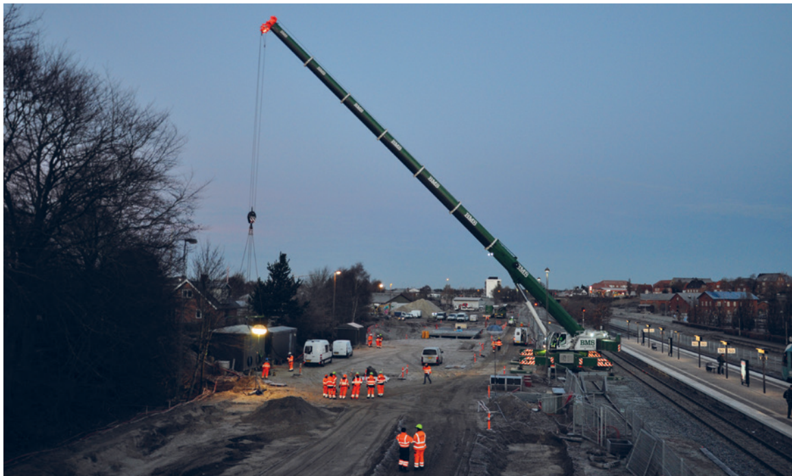
FLYTNING. En kran med en auktionsradius på 300 meter var nødvendig for at få flyttet hytterne. Foto: Banedanmark
