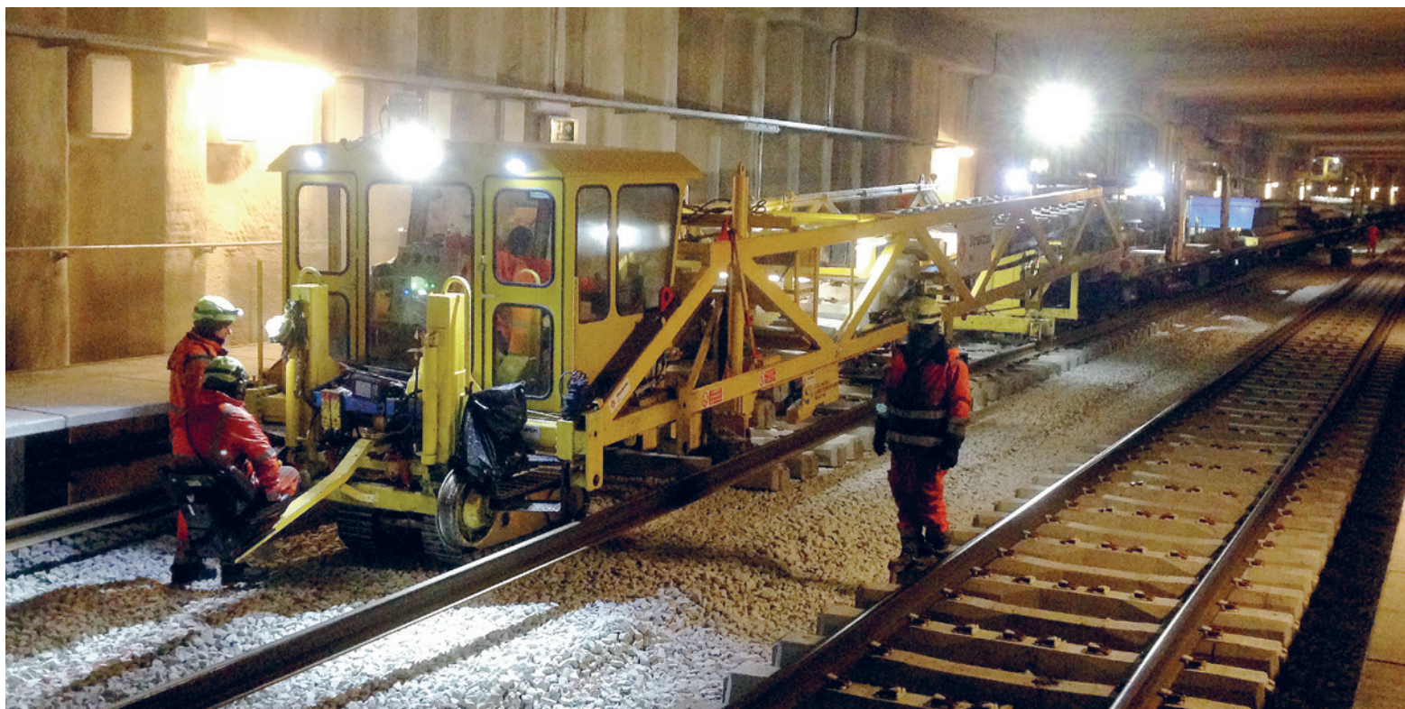
DEN NYE BANE KØBENHAVN-RINGSTED. Sporlægningsmaskinen på arbejde i Kulbanetunnelen i Valby, hvor de sidste skinner blev lagt den 8. februar.
