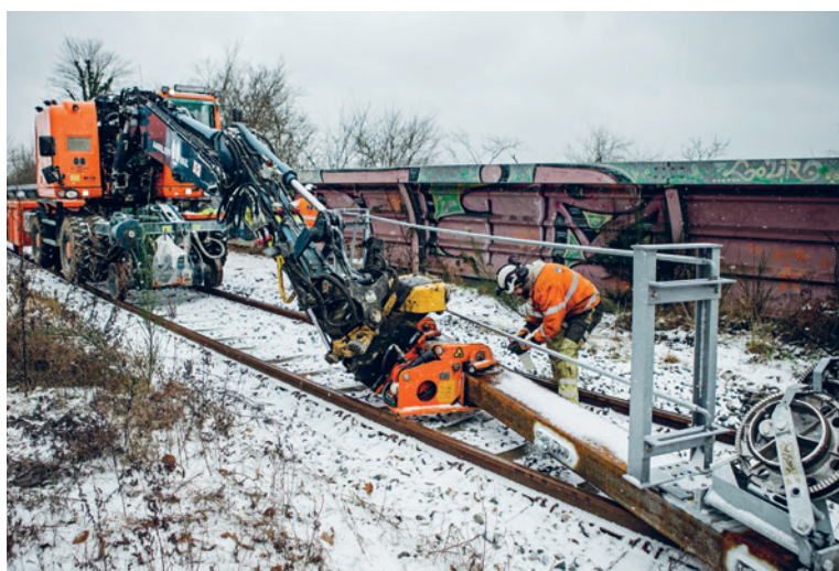
TESTANLÆG. Der bliver bygget et over 700 meter lang testanlæg til kørestrøm i Middelfart. Anlægget, der står klart i begyndelsen af maj, er let tilgængeligt for både kursister og arbejdskøretøjer, og der er egnede værkstedsbygninger ved sporet. Foto: Robert Atterman
