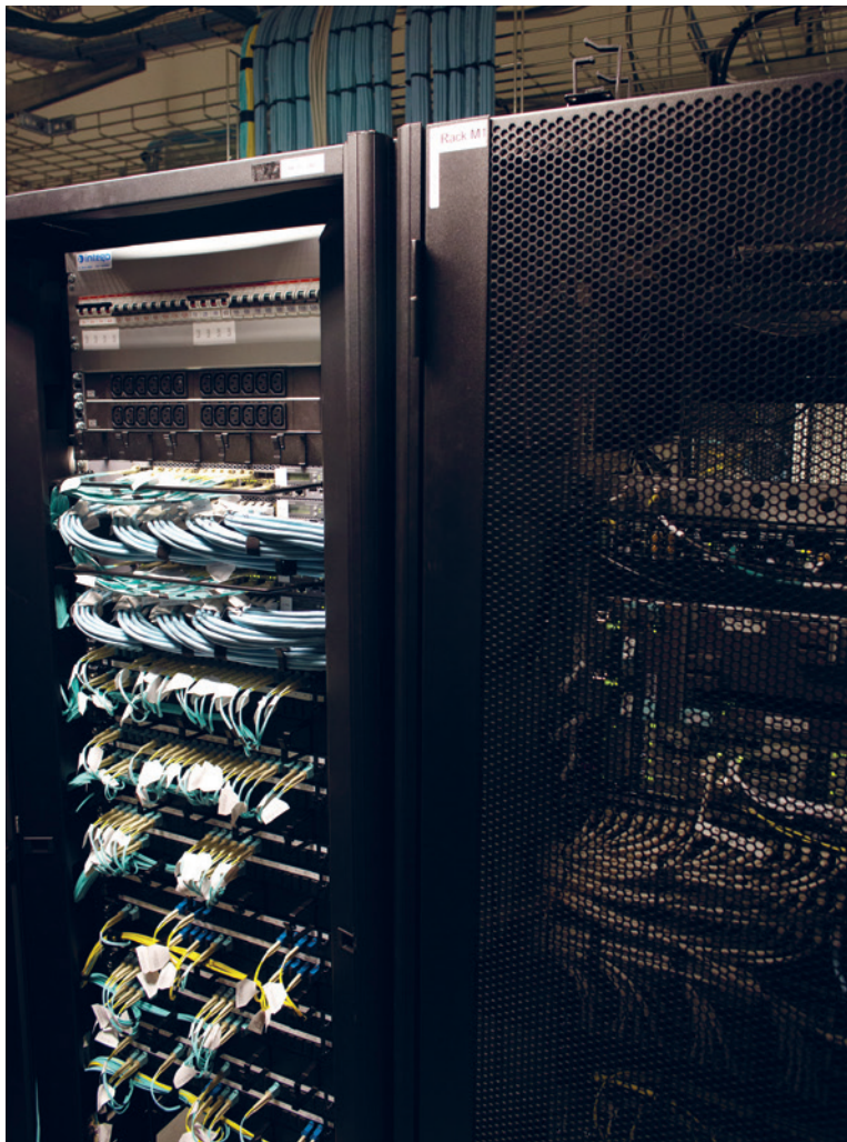
HURTIGT. Der var sat 12 timer af til opgraderingen af GSM-R-anlægget, men allerede klokken 2 om natten var den gennemført. Foto: Peter Elmholt
