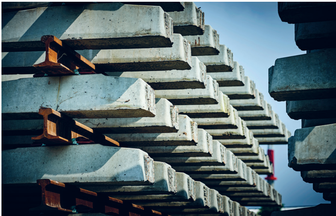
KLAR TIL SPORFORNYELSE. I weekenden begynder sporfornyelsesprojektet på Kystbanen, der varer frem til den 6. august. I år gælder det strækningen mellem Helsingør og Rungsted Kyst. Næste år afsluttes projektet med strækningen Rungsted Kyst-Hellerup. Foto: Jesper Blæsild
