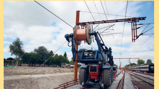
RINGSTED. I Ringsted brugte Banedanmark blandt andet sommeren til at trække kabler på de nye kørestrømsmaster ved sporene til Den nye bane København-Ringsted. Foto: Banedanmark
