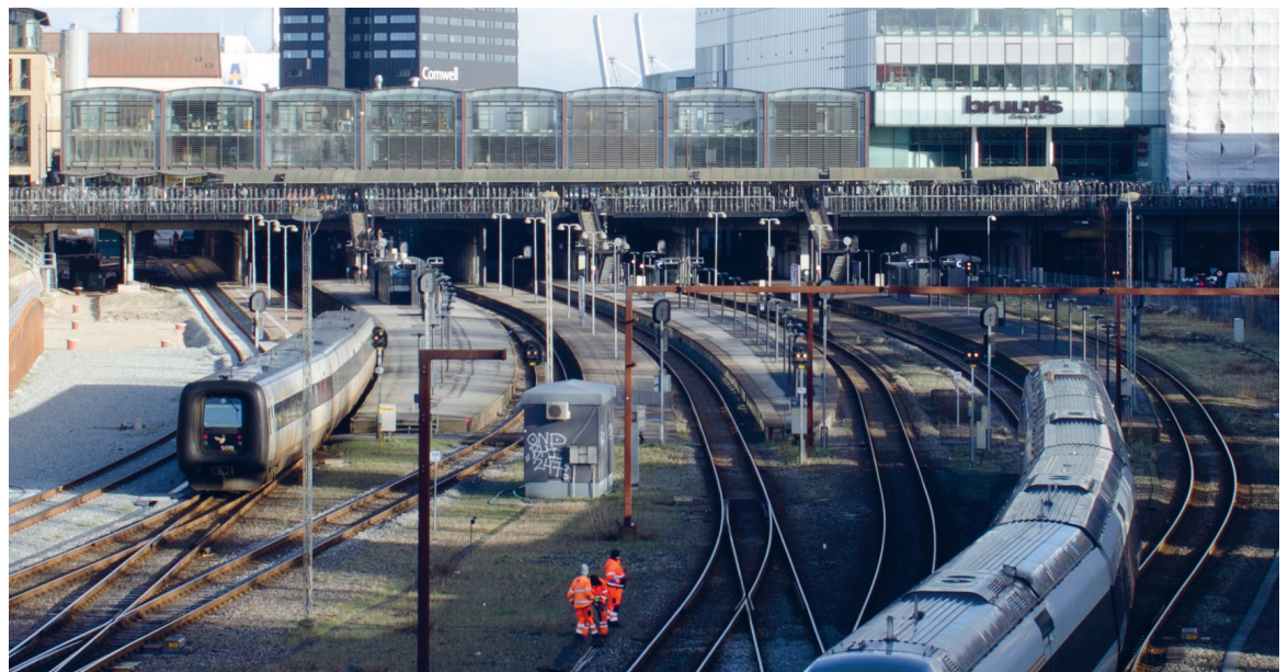
AARHUS H. Der har været massiv interesse for Bruuns Bro og løsningsmodellerne for, hvordan der kan blive plads til kørestrømsanlægget under broen. Foto: Jens Hasse/Chili
