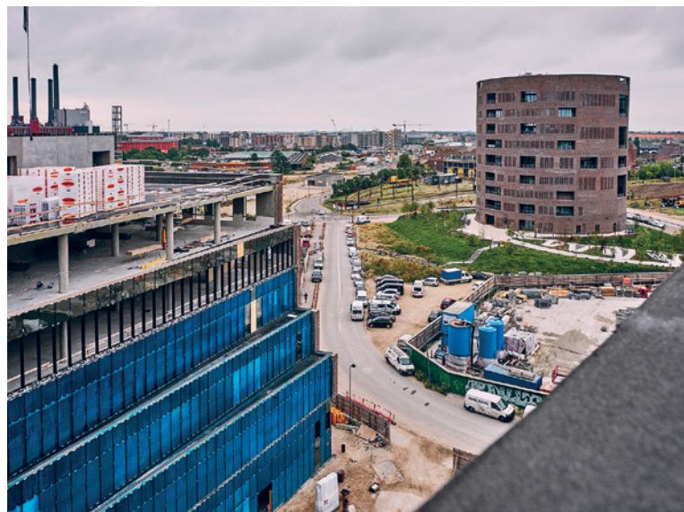
TRE ADRESSER. Planen er, at vi på lidt længere sigt er til stede på tre adresser i København: Vasbygade, Trafiktårn Øst og Kalvebod Brygge. Foto: Christoffer Regild
