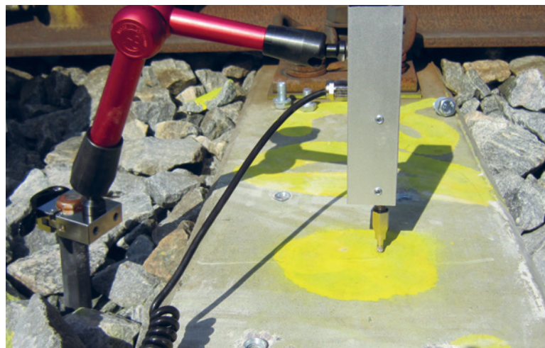
SENSORER. Der er på et sporskifte i Tommerup monteret tre displacementssensorer, der måler hvor meget svellen bevæger sig op og ned under togpassage. Sensoren dækkes af et grå cover, så den ikke bliver skadet af genstande, der hænger ned fra toget, eller ballaststen. Foto: Banedanmark
