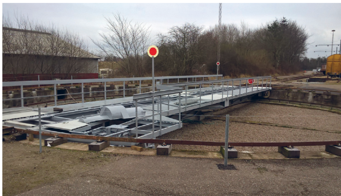
DANMARKS STØRSTE. Drejeskiven i Padborg har en bro på 23,9 meter, hvilket gør den til landets største. Drejeskiven har én primær funktion: Den skal bruges til hurtigt at vende lokomotiver eller arbejdskøretøjer, så der ikke skal rangeres unødigt rundt. Foto: Banedanmark
