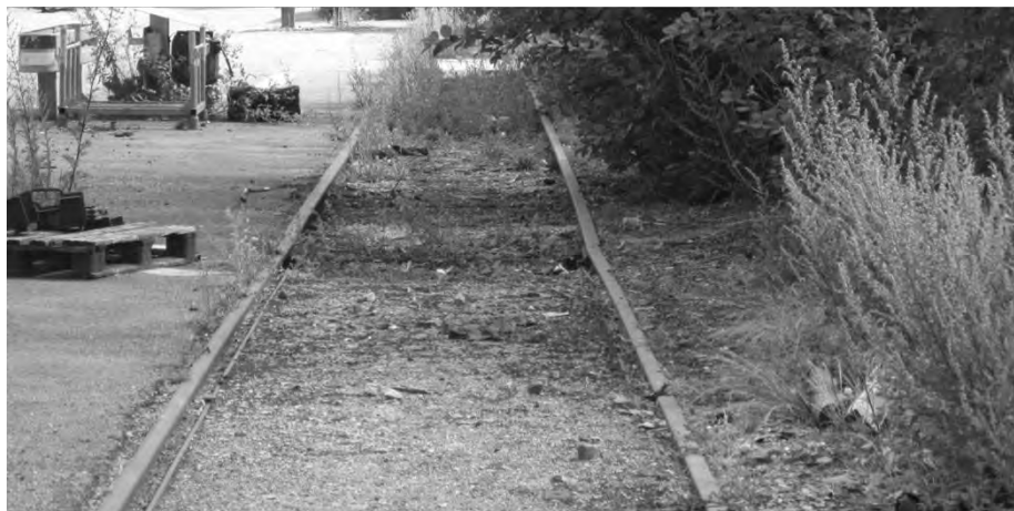
Figur 335 – Snæver sporvidde forårsaget af dårligt laskestød
