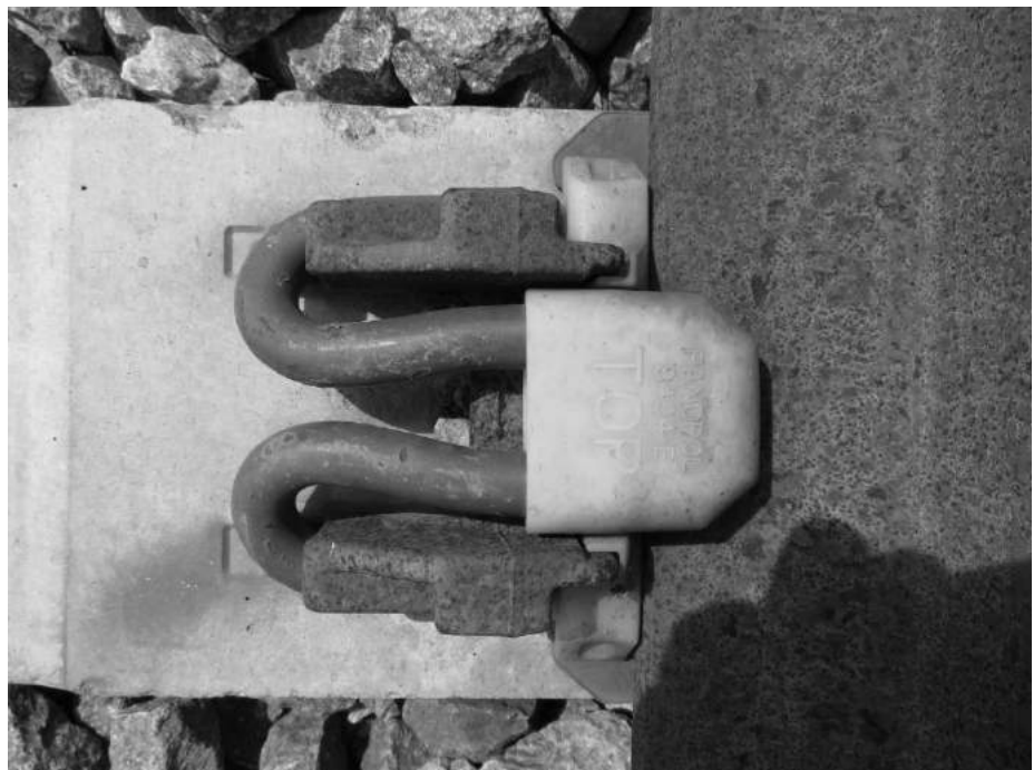
Figur 14 – Fastclip type FC på S99 svelle
