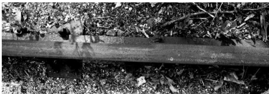
Figur 99 – Br.æ.-skinne med kraftigt sideslid, lagt i så slidet vender udad
