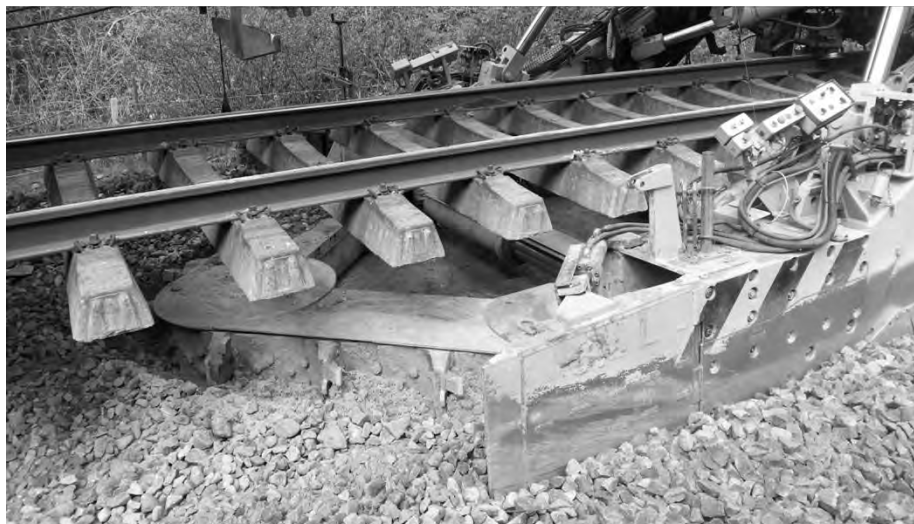
Figur 54 – Kæde til opsamling af underballast
