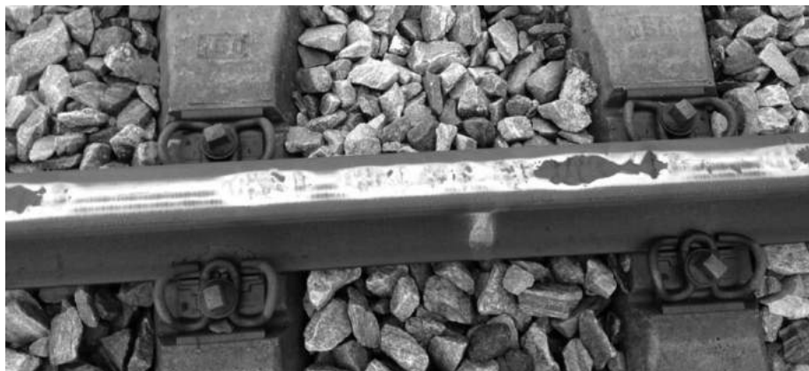
Figur 107 – Skinnepletter (squats) med afskalning
