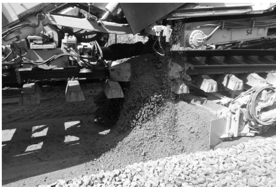
Figur 56 – Ilægning af ny underballast
