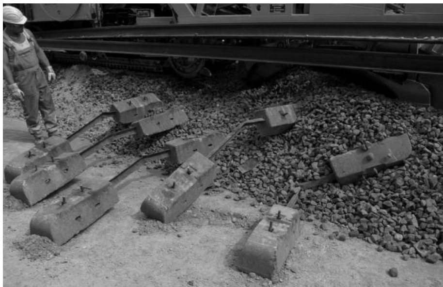
Figur 84 – To-bloksveller udtaget af sporombygnings- tog i 2010
