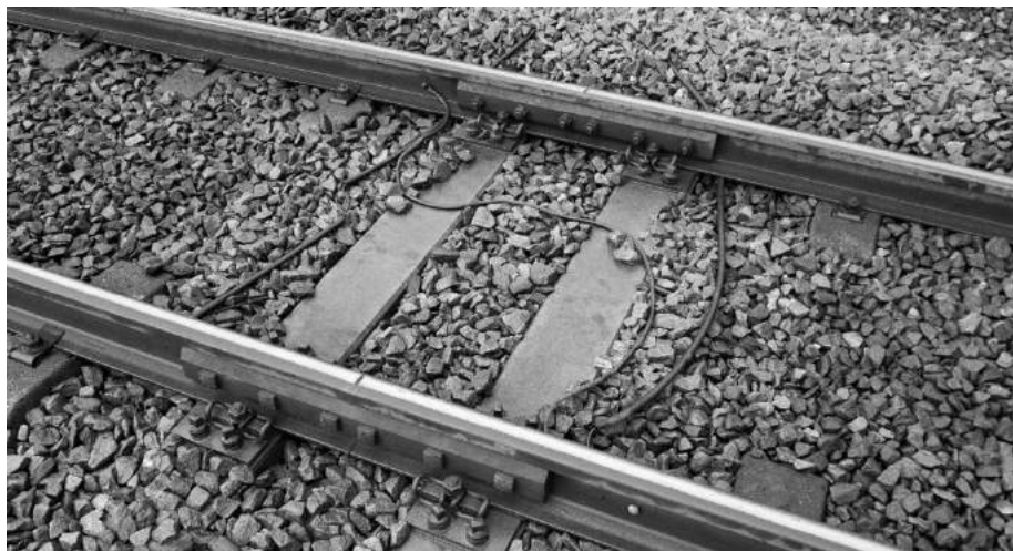
Figur 222 – Rette isolerklæbestød på SP90-sveller
