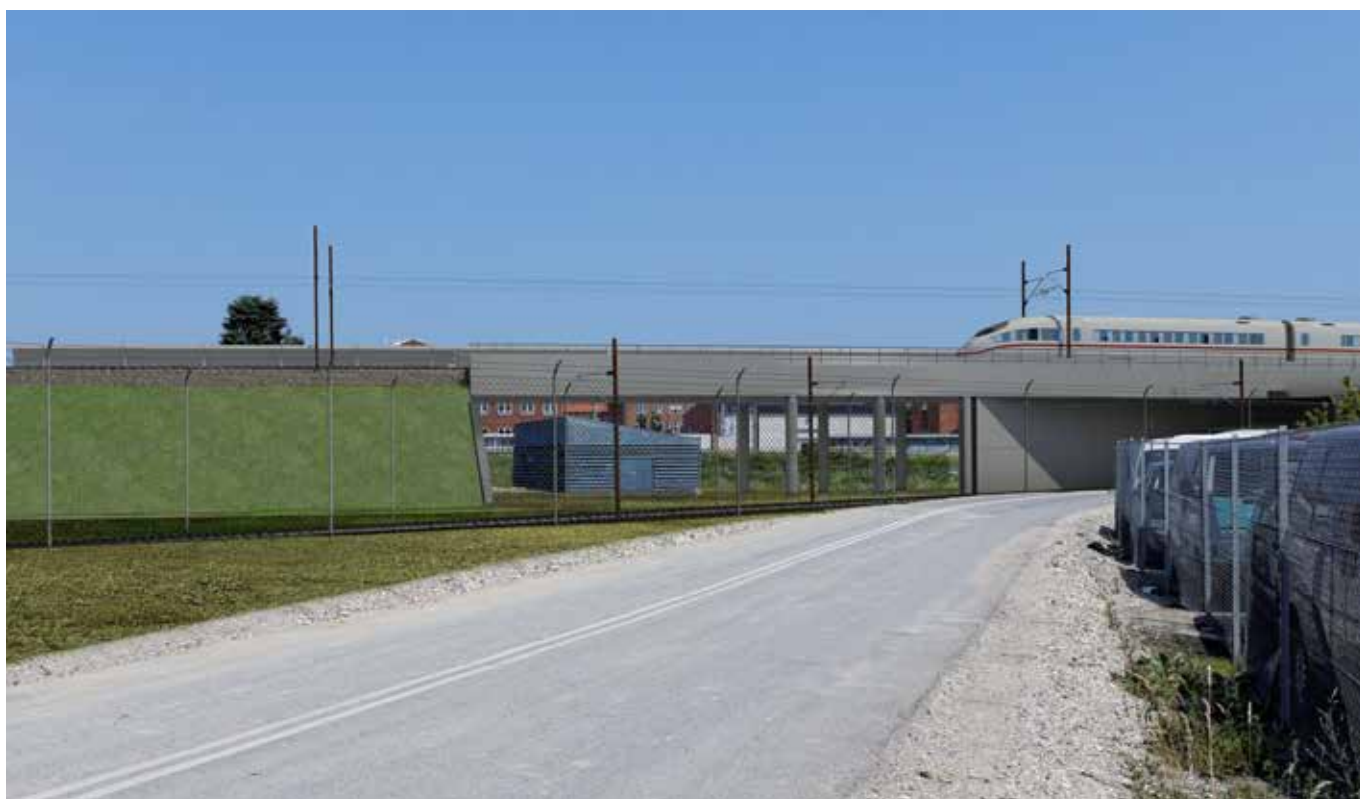
Figur 27 Punkt 3. Udsigt mod nordøst fra Retortvej. Den alternative støjskærm på den nye jernbanebro hæver højden af anlægget. Til gengæld er der en vis visuel forbindelse til nordsiden under broen, som ellers blokeres med den forhøjede støjskærm i 0-alternativet og hovedforslaget.
