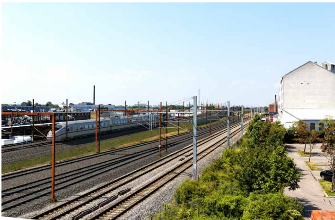
Figur 15 Punkt 1. Udsigt mod nordvest fra parkeringshus på Poul Reichhardts vej. Visualiseringen viser jernbanebroen med dæmningsanlæg og brokonstruktion til venstre for Den nye bane København-Ringsted og det eksisterende baneanlæg.
