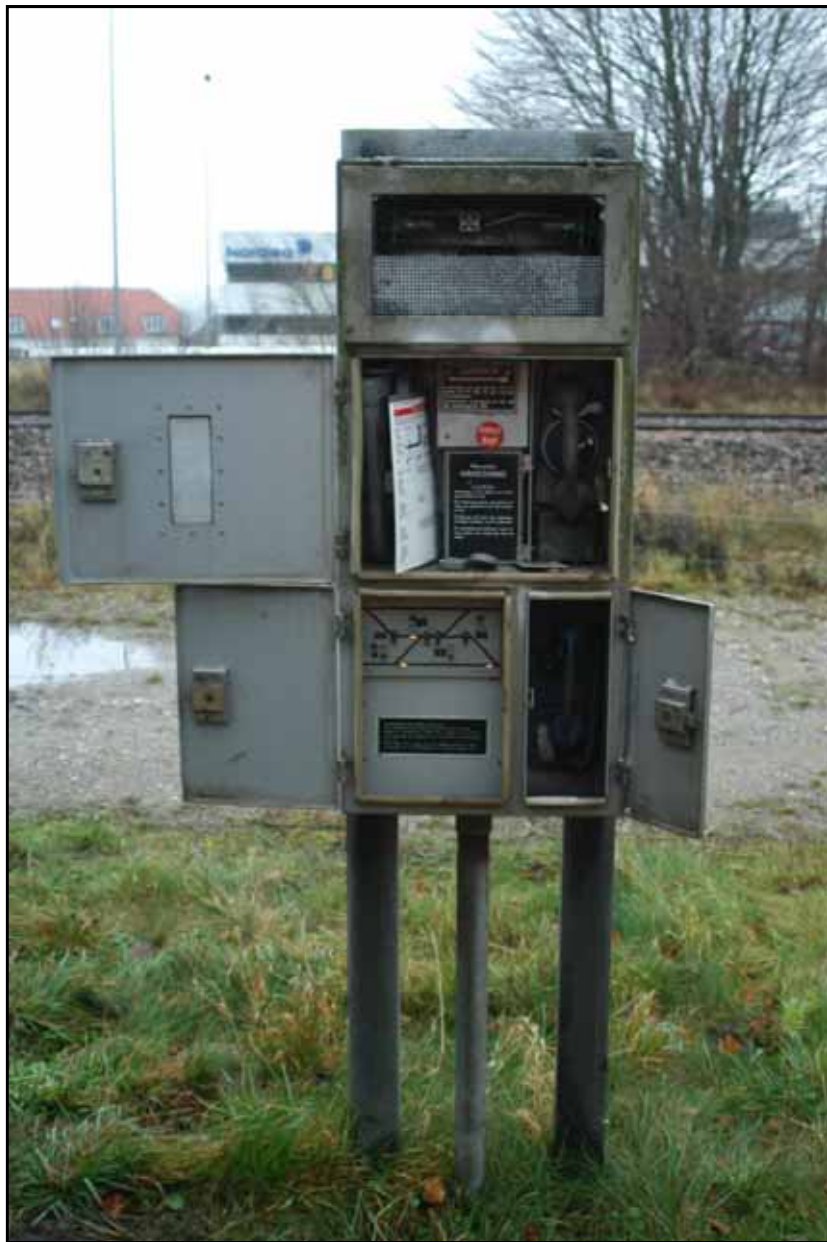
Betjeningskab type DSB 1953, 1953/54, 1954, 1972, åbent
