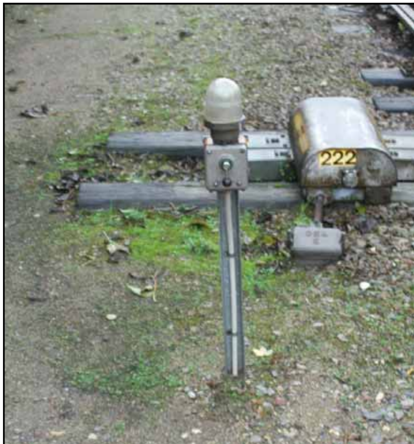
Centralaflåst sporskifte med el-stedbetjening
