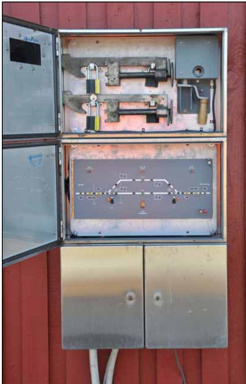
Betjeningskab type DSB 1954 PAPP, åbent
