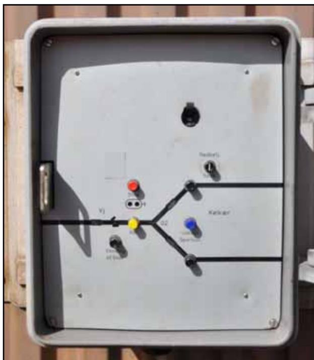
Sportavle (nødpanel) type DSB 1977, åbent
