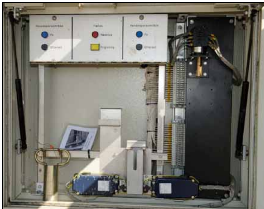
Skab med nødpanel type DSB 1990
