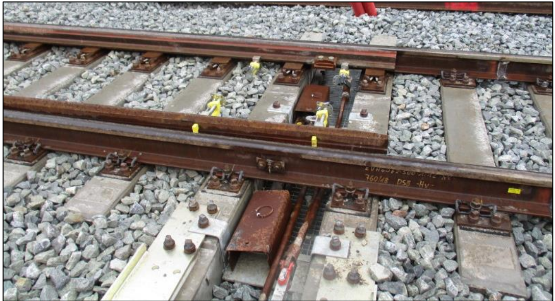
Billedet viser placering af låsebolte.
