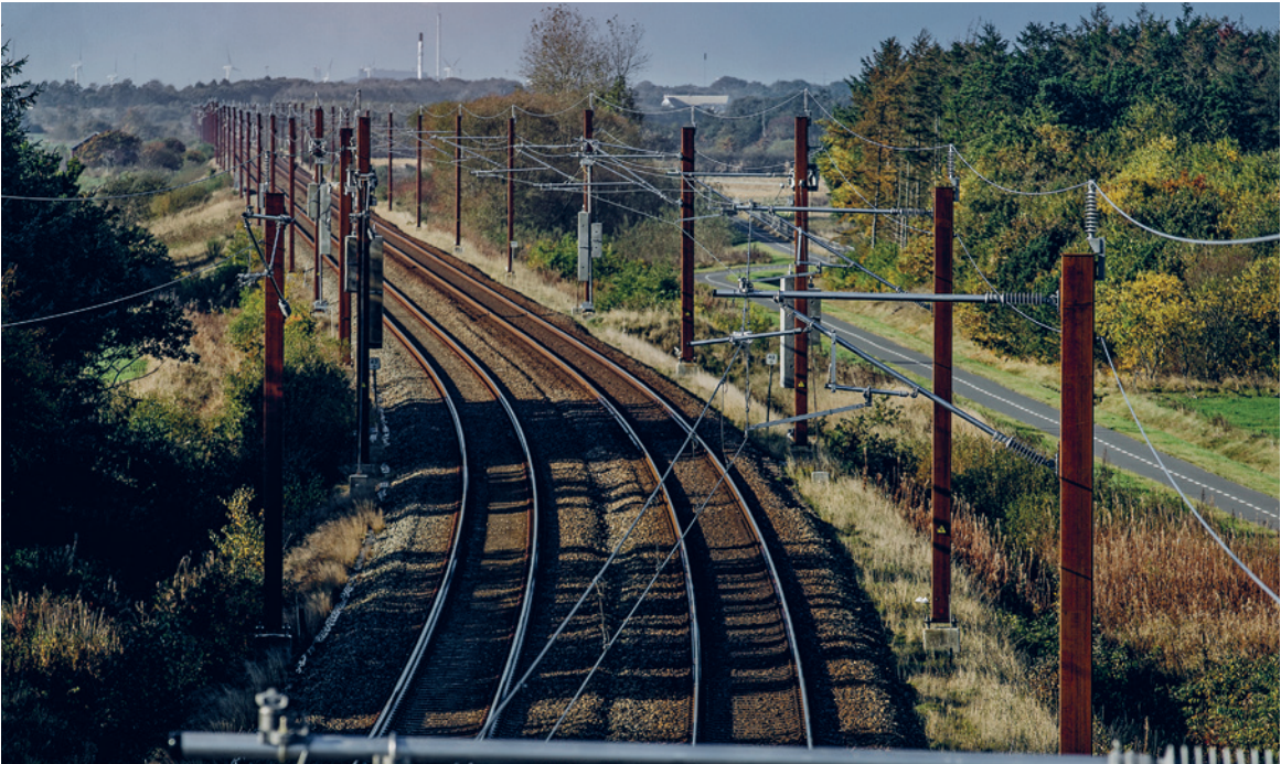
ELEKTRIFICERING. En elektrificeret jernbane kræver strøm. Både mellem Esbjerg og Lunderskov og på fremtidige strækninger vil der blive bygget autotransformere, som får strømmen fra en feeder-ledning, der er en del af køre- strømsanlægget. Foto: Robert Attermann
